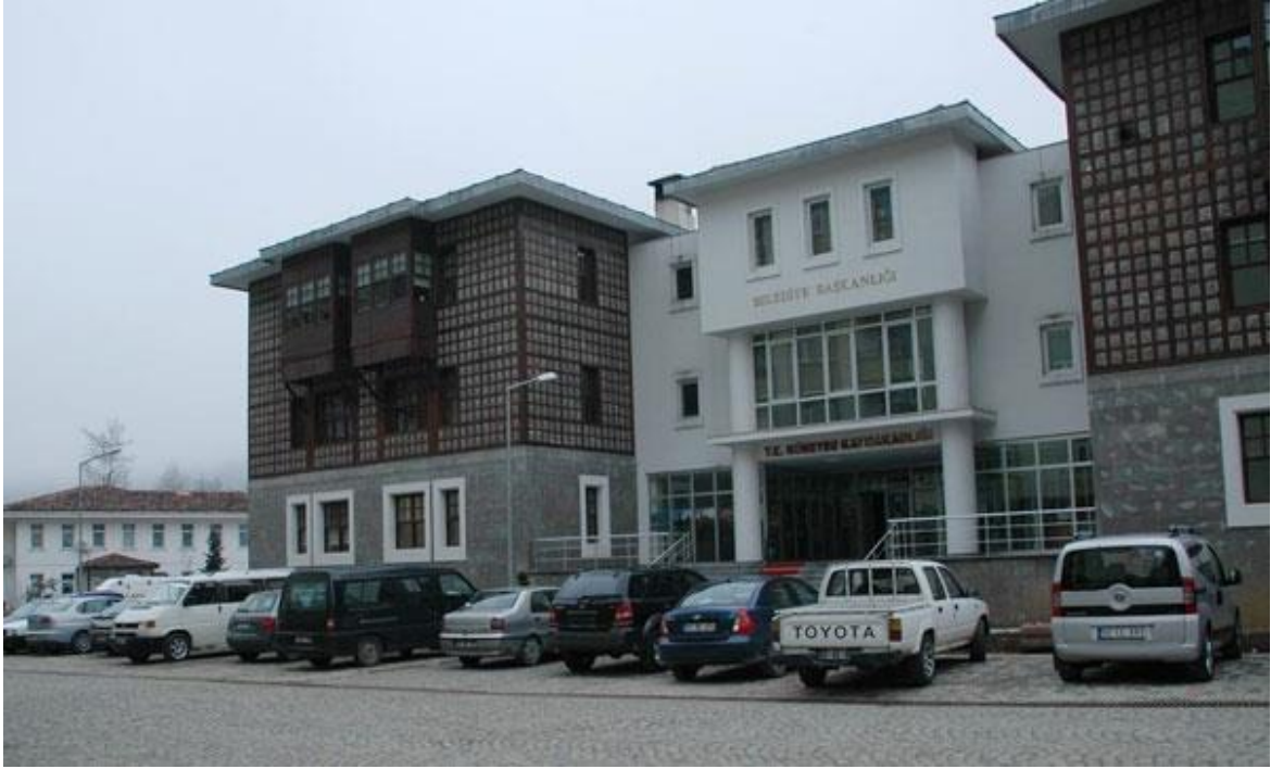
Güneysu belediye binası
